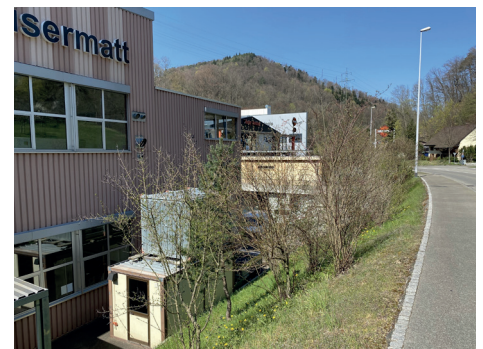
begrünte Böschungen entlang der Kantonsstrasse
