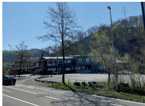
Hauptzugang mittig des Areals: asphaltierte und chaussierte Flächen
