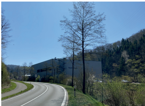
Blick von Norden auf das Industrie-Areal: nach einer Engstelle am Talboden zeigt sich das Industrieareal
